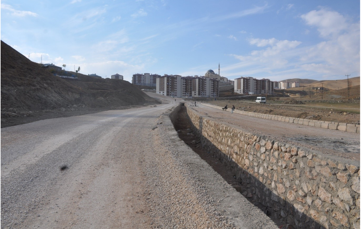
TOKİ YOLU ASFALT YAIMI
