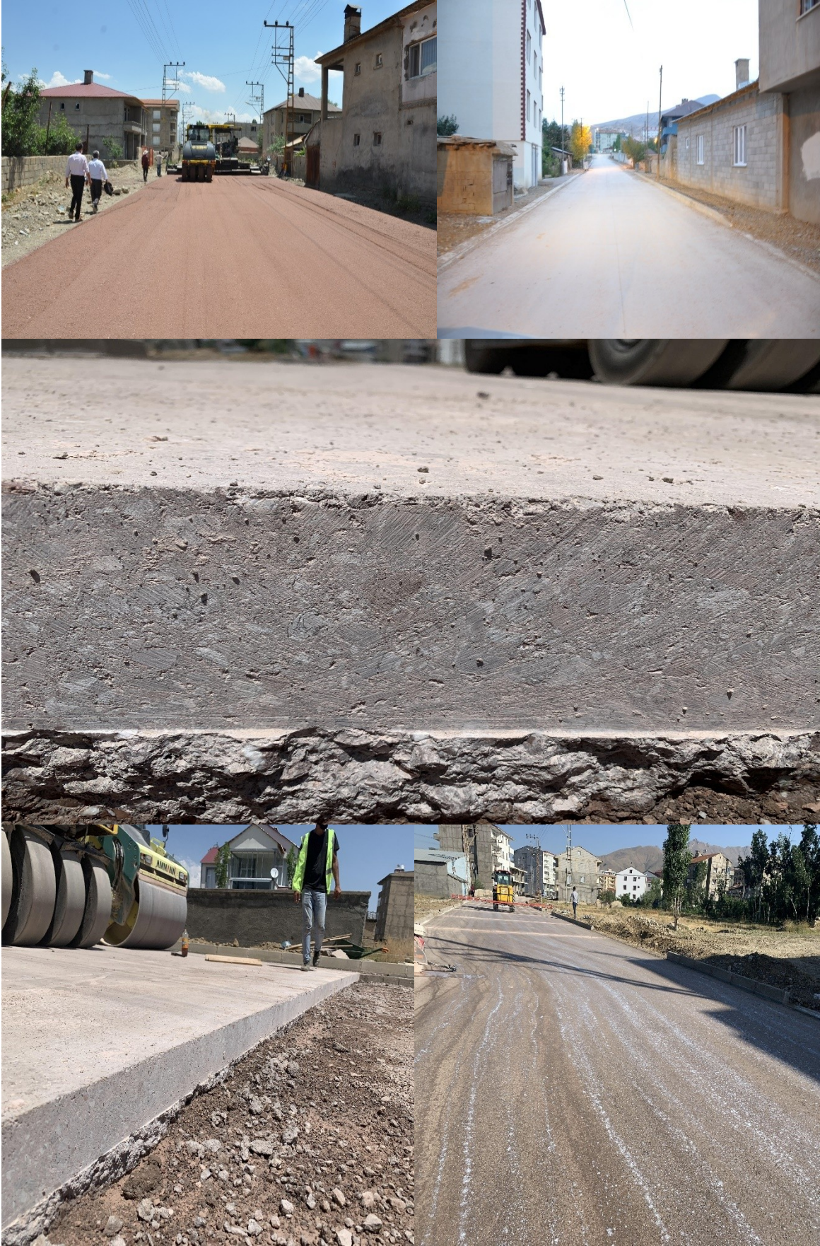
Asfalt Yol Yapımları Gögür Mahallesi/ 2020-2021
