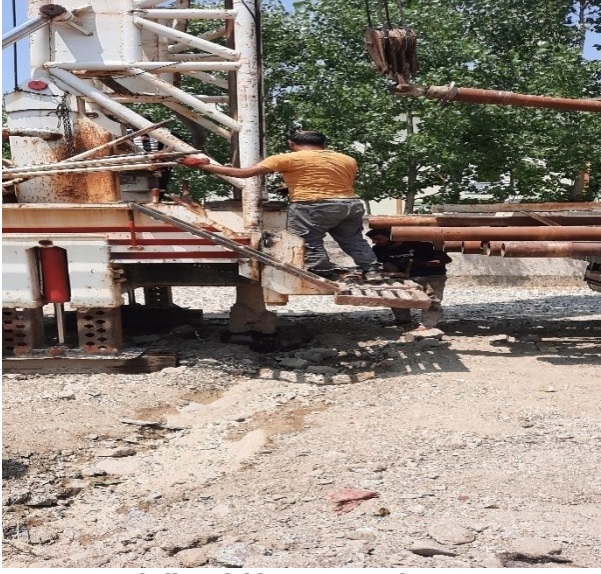
Yeni mahalle Dilekli 110 M sondaj yapımı/
