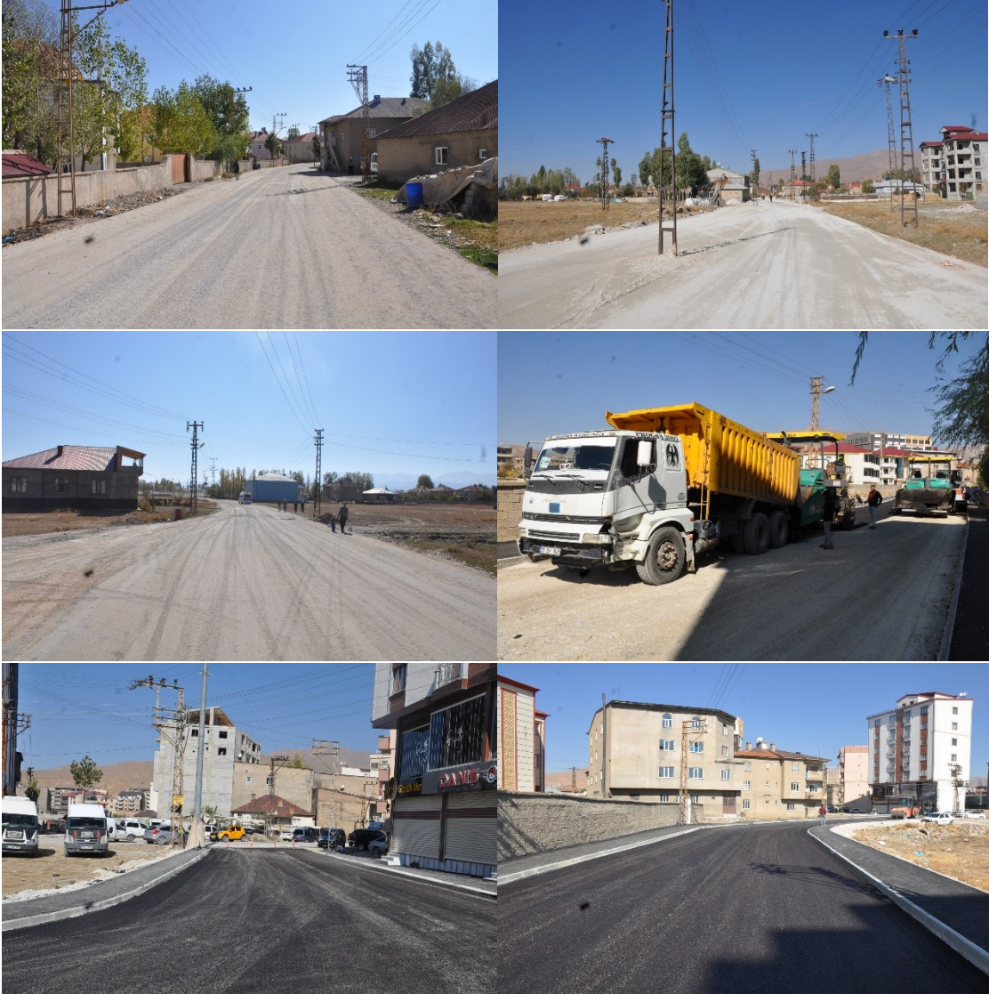
Asfalt yol yapımları
