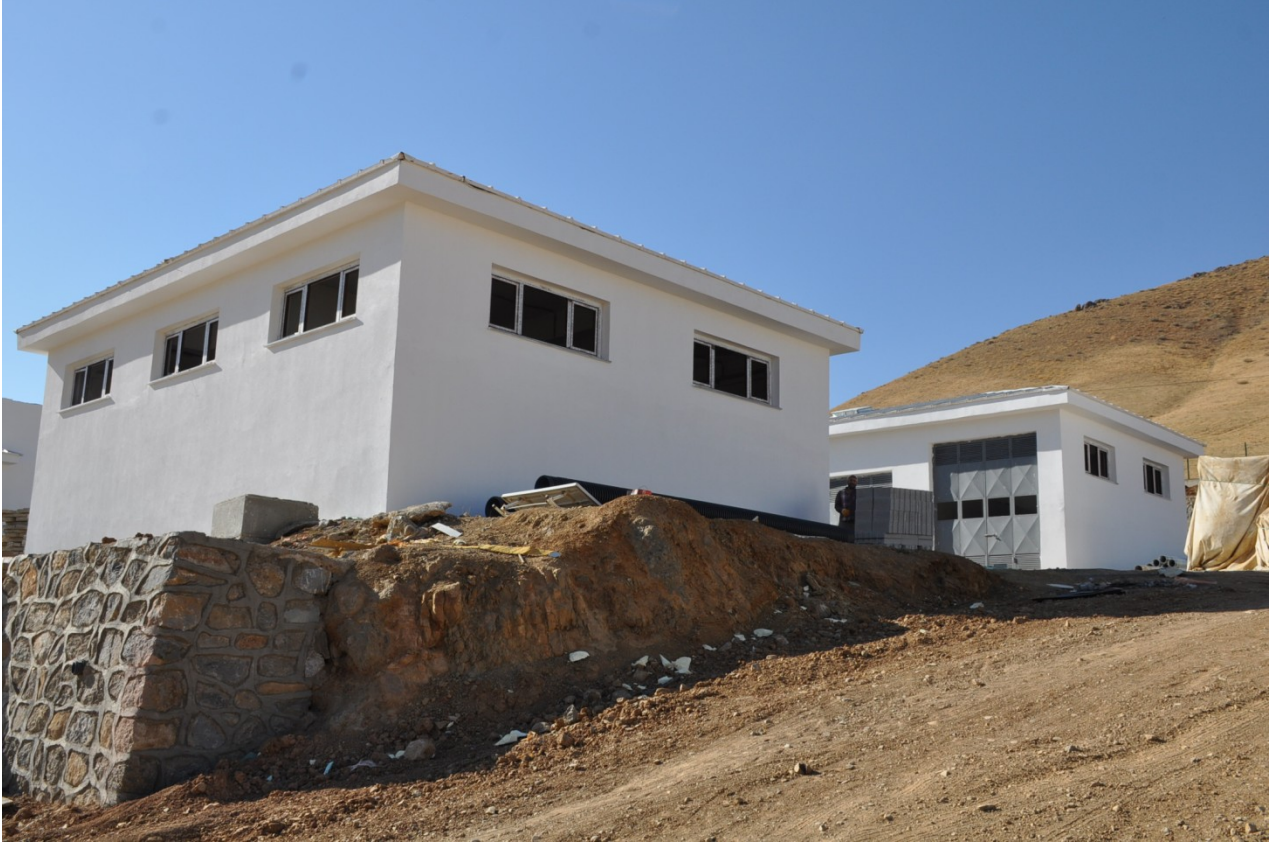
İçme Suyu Arıtma Tesisi
