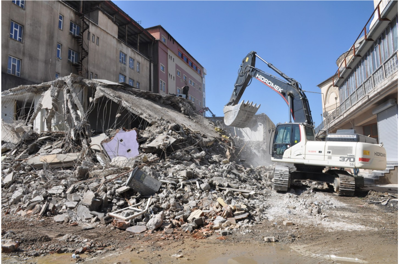
Dere Üstü yıkım ve dere ıslahı tamamlayıcı Projeler.
