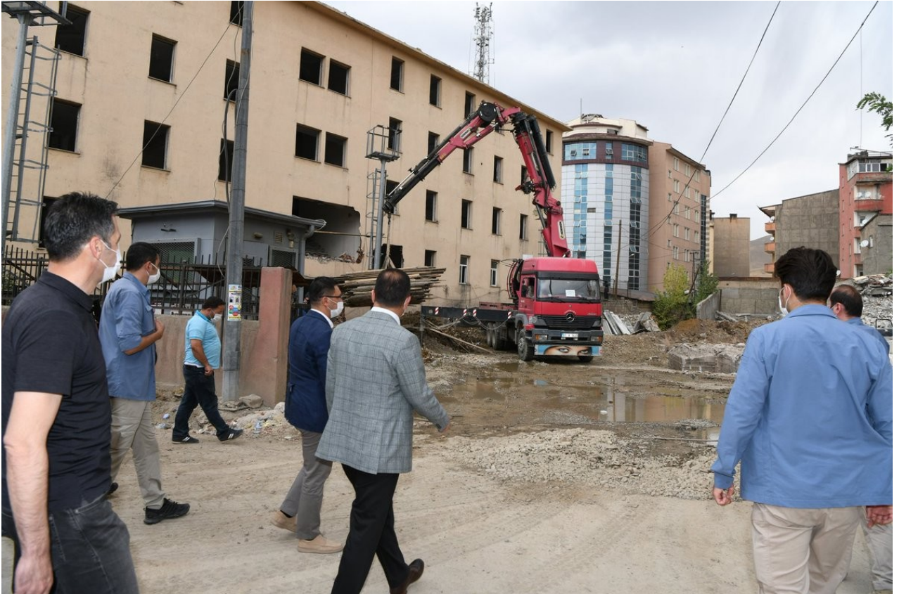
Eski Hükümet Konağının Yıkımı ve Kent Meydanı projesi/Millet Parkı
