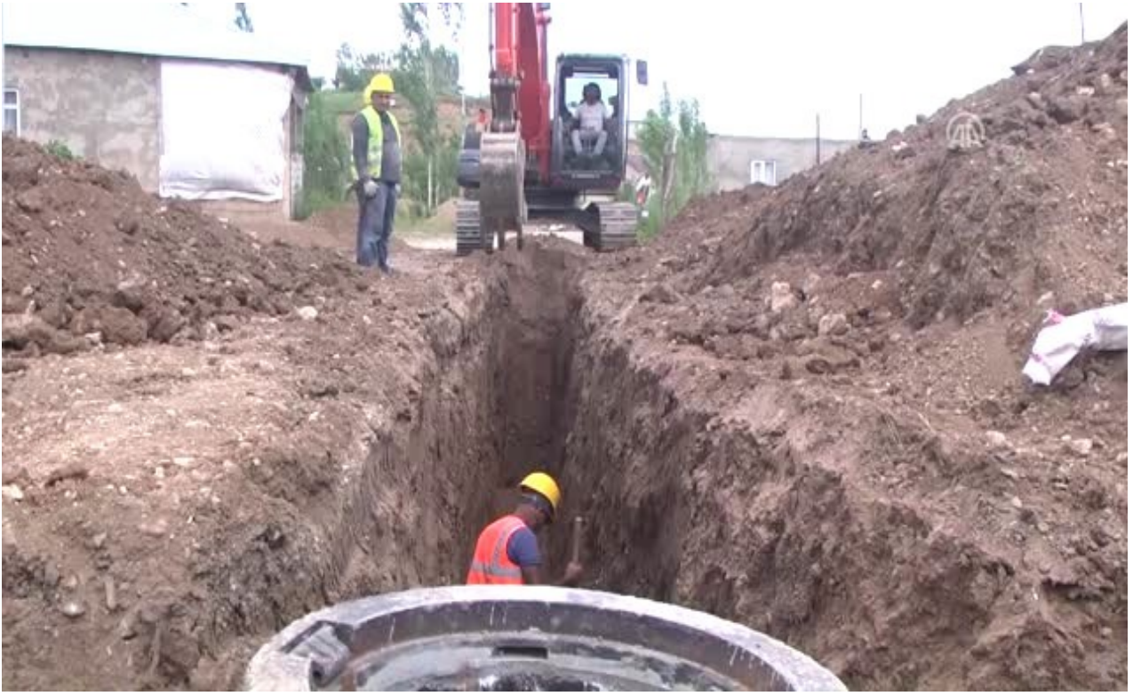
Yüksekova Yağmur Suyu Çalışmaları
