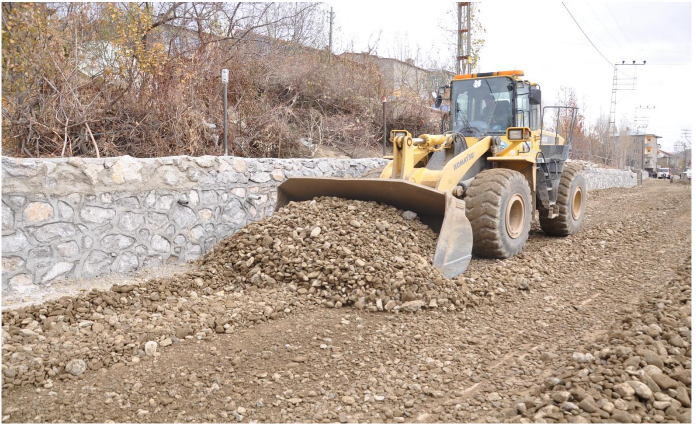
2015 İtfaiye binası yapım işi
