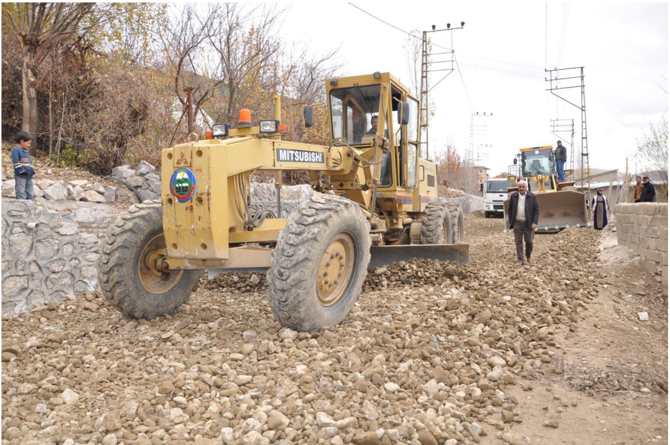
2015 Yol yapım işleri
