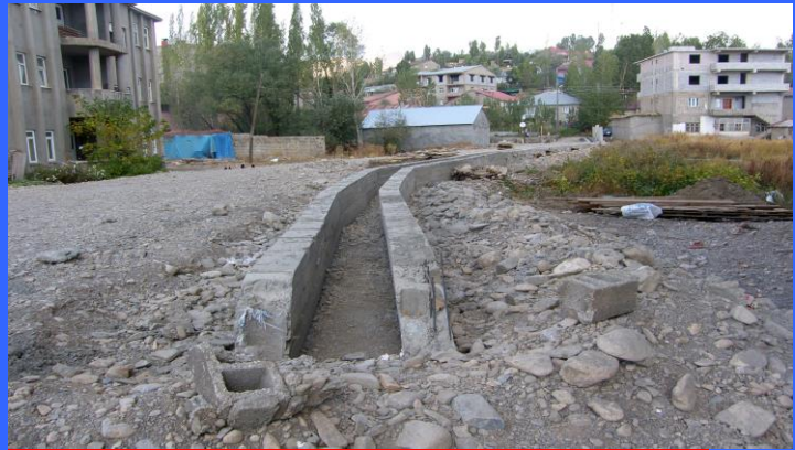
Beton Kanal Yapım işi
