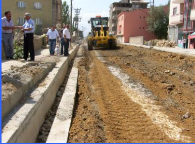
Kuruköy yolu yağmur suyu kanalı
