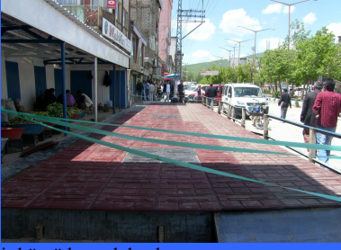
Demir köprü kauçuk kaplama
